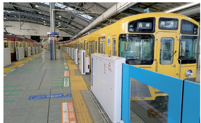
西武池袋線では池袋駅にホームドアを設置
